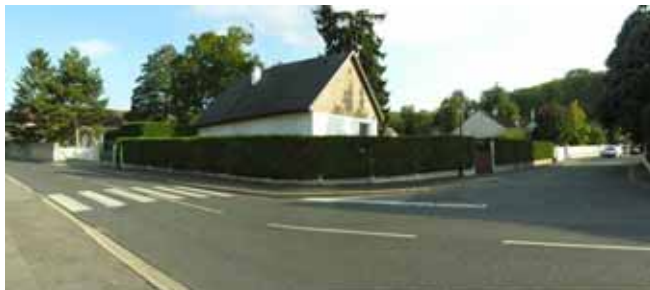
lotissement de la Raizière: paysage urbain "étanche", anonyme et indifférent au bâti ancien fleurinois; le surdimensionnement des voiries consacre la suprématie de l'automobile sur les piétons et vélos
