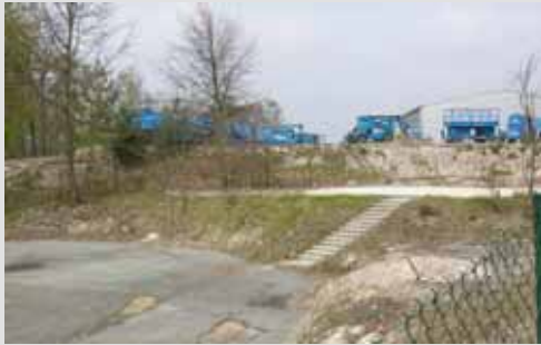
plateformes en déblais-remblais au-dessus de l'école, à 50 m environ de la cour de récréation qu'elles dominent d'un haut talus
