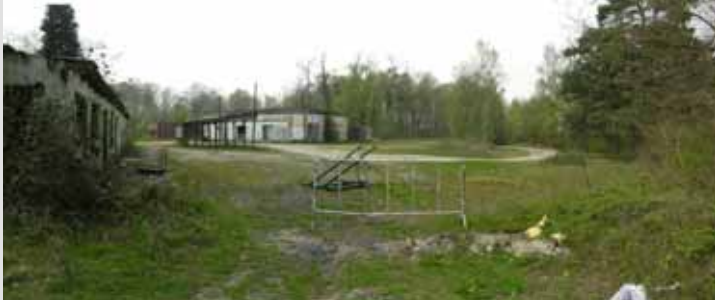
anciens bâtiments d'accueil, en regardant vers la rue de la Vallée
