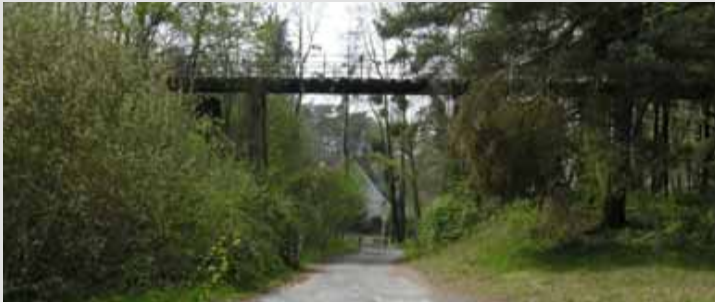
anciennes installations techniques : le viaduc du petit train; au fond, la rue de la Vallée et les premières maisons du lotissement Roquesable
