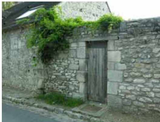
façade sur rue aveugle et mur > 2m
